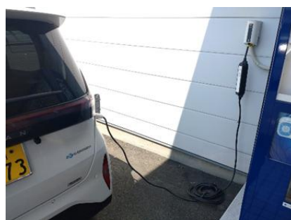
本社入口に充電エリアを設置し電気自動車の使用を継続中です。
